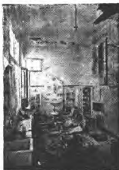
Разрушенный госпиталь „Saint Carlos“ в Мадриде
