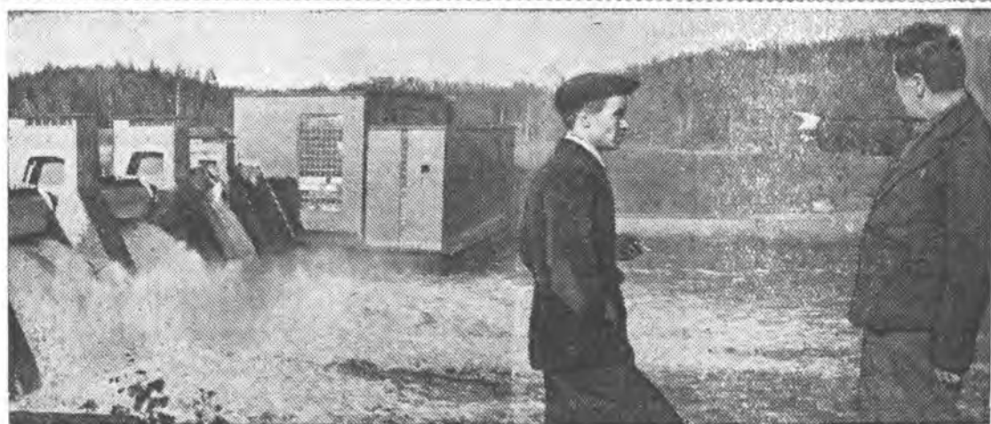
Гидростанция в Раухнала (Карело-Финская ССР). На снимке: начальник машинного цеха орденосеца В. Л. Леонтьев (справа) и сменный мастер В. А. Вальцхер у сооруженной гидро-станции. Фото ТАСС
