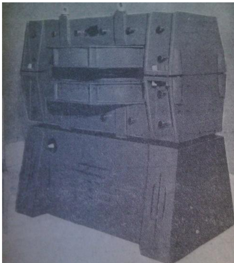
Рисунок 1 – Бетатрон на 25 МэВ
