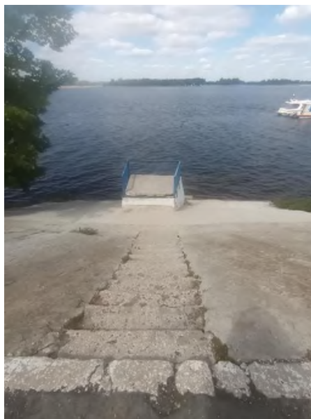
Рисунок 4 - Смотровая площадка (фото автора)
