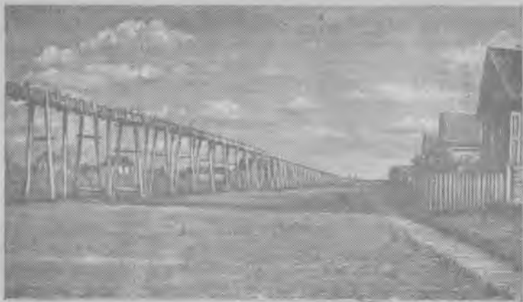
Ирригационное сооружение в колхозе имени Ленина, Балаковского района.
