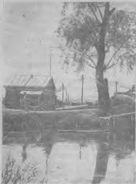
Посельская гидро- электростанция мощ- ностью в 60 киловатт, построенная в 1946 г. колхозниками трех сел Черкасского рай- она.
