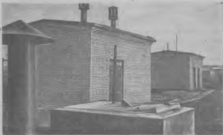
Елшанский газовый промысел—крупное промышленное предприятие, оборудованное сложной техникой. На снимке: общий вид одной из эксплуатационных газовых скважин промысла.
