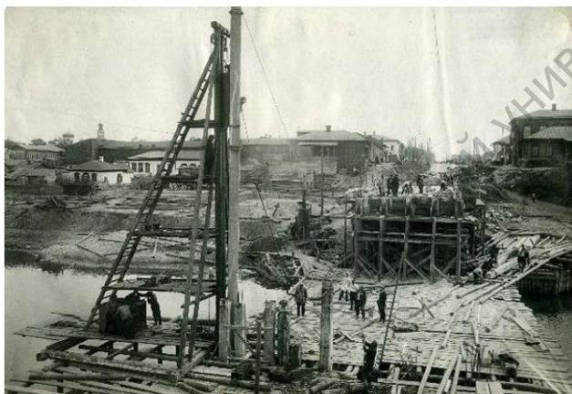
Рис. 5. Установка опор
