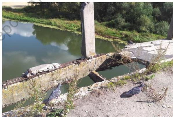
Рис. 2. Стяжки разломившегося сооружения
