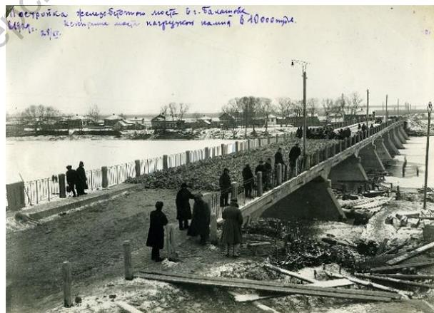
Рис. 6. Испытание нагрузкой
