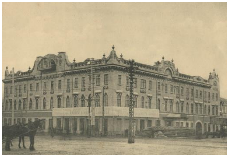
Ведётся перестройка здания. Сверху и по фасаду пристраиваются многочисленные декоративные элементы, в левой части - устанавливаются львы, но он пока закрыт
