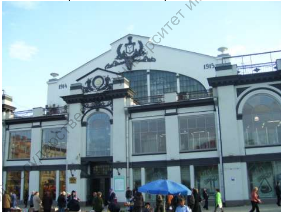
Крытый рынок. Архитектор В. А. Люкшин
