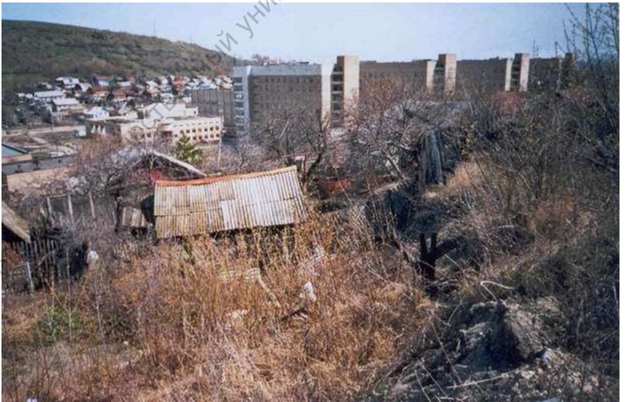
Рисунок 34 Трещина отрыва за домами №№ 81 и 83 (Смирновское ущелье)
