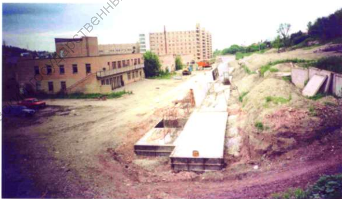
Фото 2 : Противооползневые защитные сооружения в Смирновском ущелье
