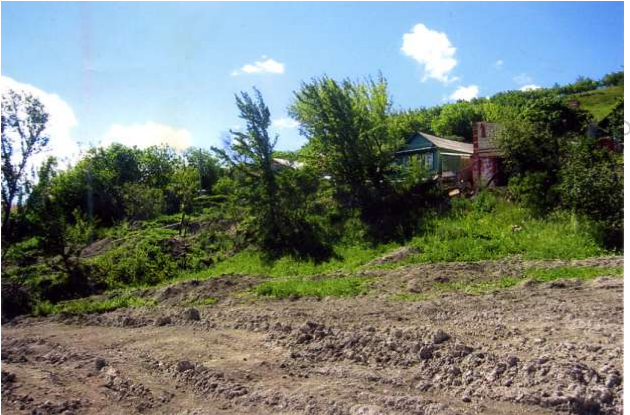
Рисунок 33 Разрушение сооружений в оползневой зоне (Смирновское ущелье)
