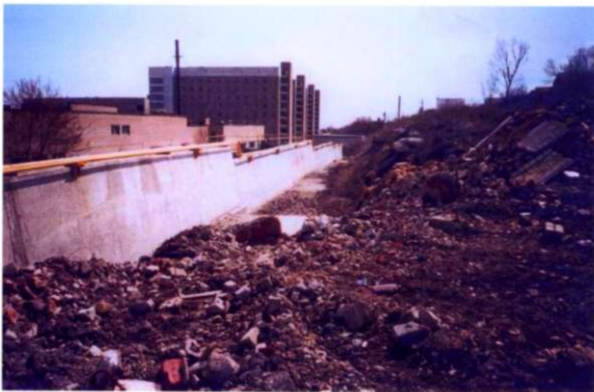
Фото 1 : Противооползневые защитные сооружения в Смирновском ущелье
