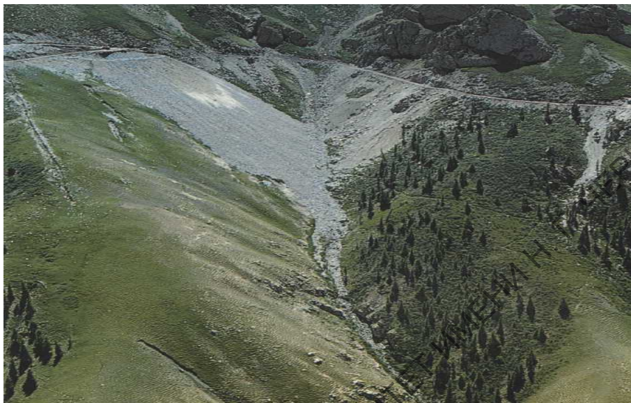
Рис. 3. Осыпной участок горного склона
