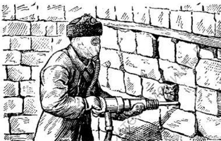
**Рис. 10.** Пробивание отверстия в стене убежища для подачи очищенного воздуха от вредных веществ.
